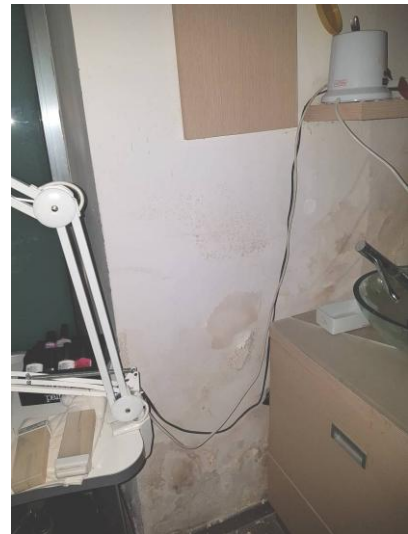
Foto n.7 e n.8 – sala per trattamenti estetici, particolari delle infiltrazioni e dei distacchi dello strato superficiale di finitura
