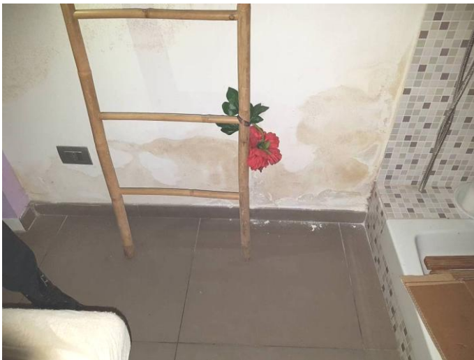
Foto n.7 e n.8 – sala per trattamenti estetici, particolari delle infiltrazioni e dei distacchi dello strato superficiale di finitura
